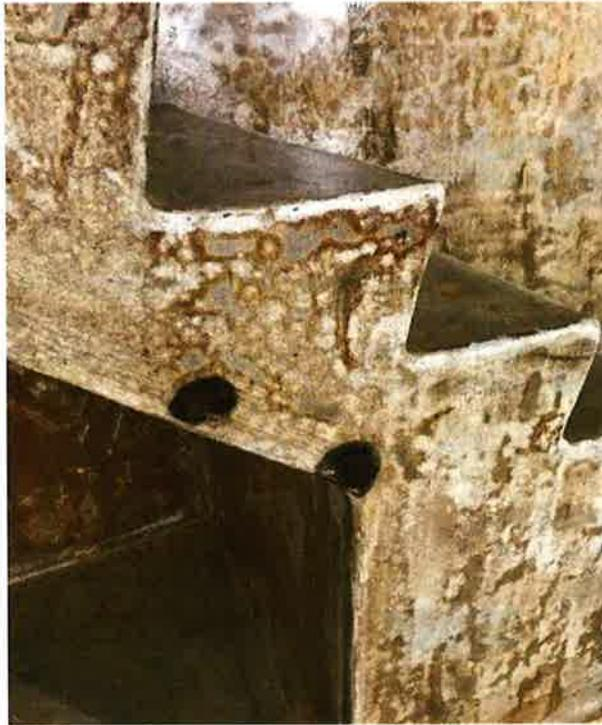
Die Oberflächen sind fleckig, stark angegriffen und aufgeweicht und der Beton bröckelt.
