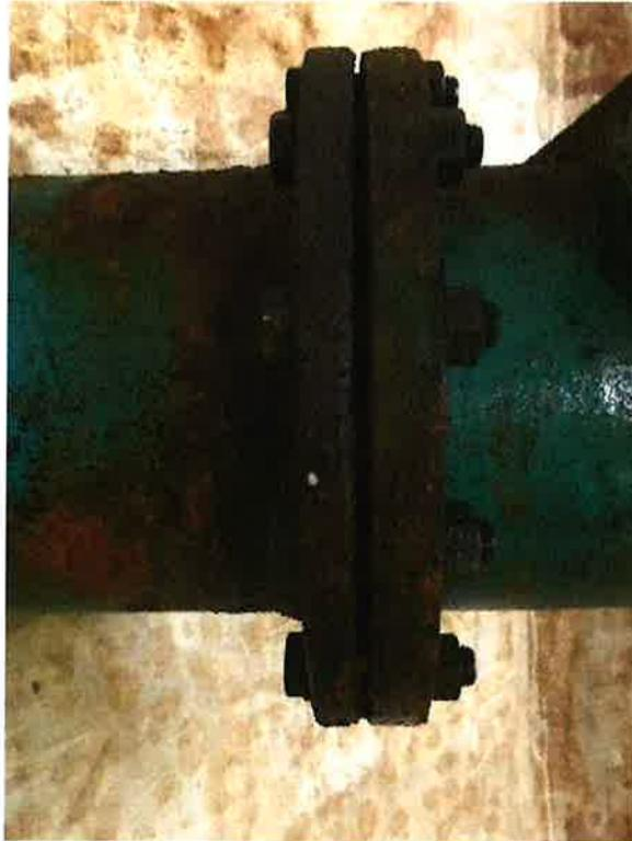
Die Verbindungsleitungen zwischen den beiden Kammern sind teilweise durchgerostet.
